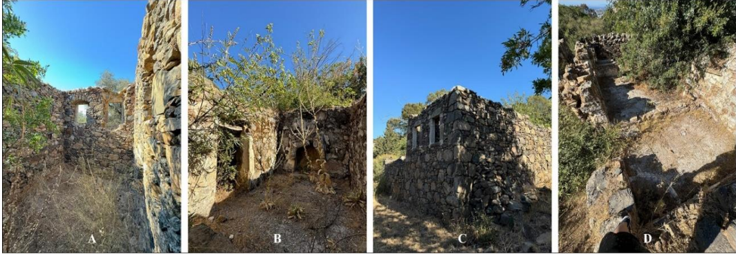
Şekil 7: 678 Ada 21 No'lu Parseldeki Tek Katlı Konut Tipinin A ve B Ek Halinin İç Mekan Görüntüleri, C Ek Hali Olan Yapının Dış Görünüşü, D İlk Halinin Yaşam ve Yatma Alanı (Kaynak: Ümran Arıcı'nın Kişisel Arşivi)
