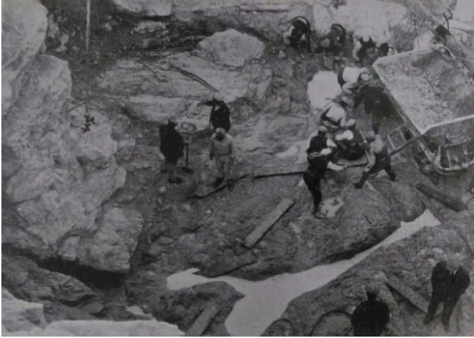
Çubuk Barajı Temel Zemininin Hazırlanması
